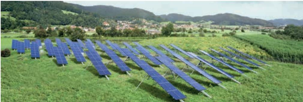
**Standort Rheinau.** 28 nachgeführte, platzsparende und einfach zu installierende SunCarrier 22 erzeugen pro Jahr insgesamt 135.000 kWh Strom.
